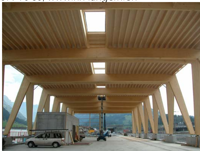
RAHMENECKEN SYSTEM GSA AM BEISPIEL EIZ FRUTIGEN (WIRKUNGSGRAD CA. 85 % BEZOGEN AUF DEN BRUTTOQUERSCHNITT)
