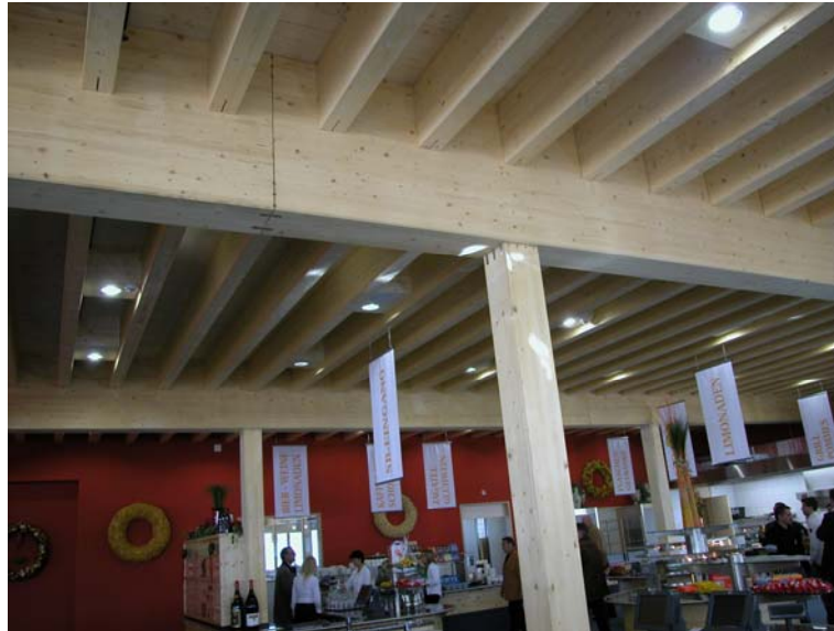
KRAFTEINLEITUNG AM BEISPIEL BERGRESTAURANT MORENIA IN SAAS FEE (MAX STÜTZENLAST. ND=1050 kN)
