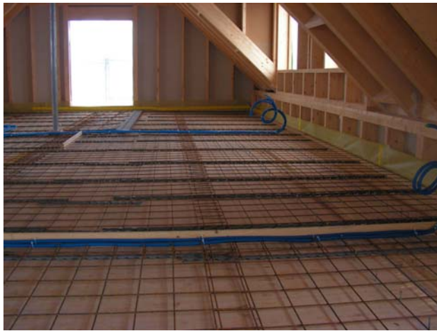
HBV bereit zum betonieren
